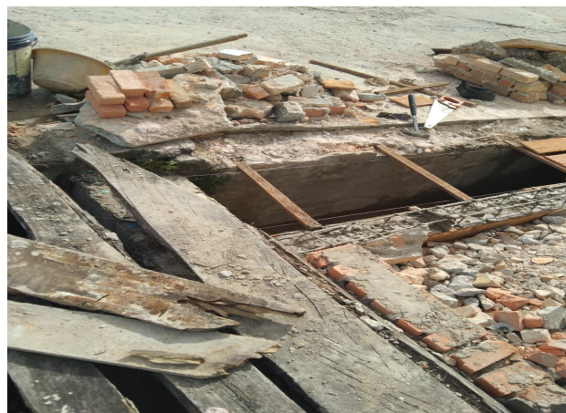
Gambar 1. Saluran air yang sedang di perbaiki warga. saluran ini sebelumnya rusak dan rawan terjadi longsor sehingga mengakibatkan air tersumbat.
