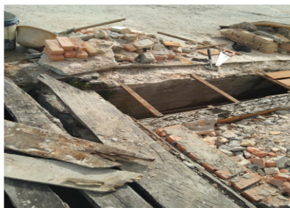
Gambar 1. Saluran air yang sedang di perbaiki warga. saluran ini sebelumnya rusak dan rawan terjadi longsor sehingga mengakibatkan air tersumbat.
