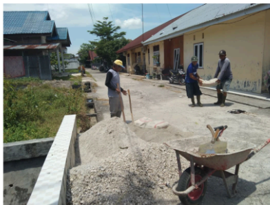
Gambar 3. Warga bergotong royong untuk memperbaiki saluran air yang rusak
