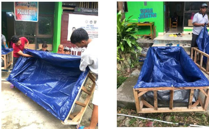
**Gambar 3.** Proses pembuatan kolam terpal
