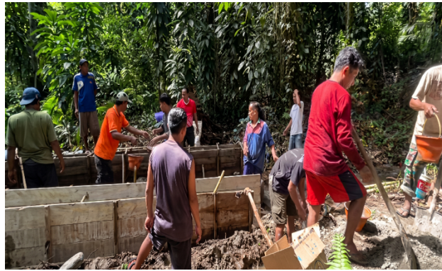
Gambar 2. Proses Pembuatan Bak Air Bersih
