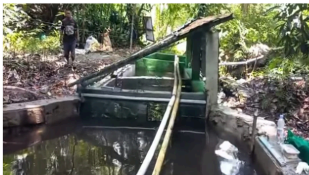
Gambar 3. Bak Air Bersih yang sudah jadi dan siap difungsikan
