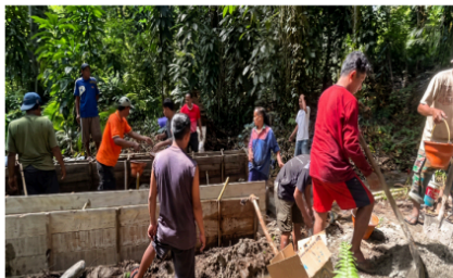
Gambar 2. Proses Pembuatan Bak Air Bersih
